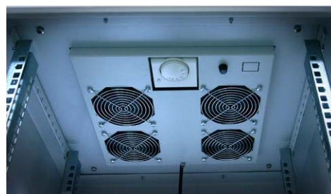
Вариант вентиляционного устройства. Верхняя крышка предназначена для циркуляции воздуха.
